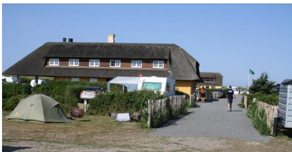
Figur 6 Servicebygning beliggende indenfor planområdet
